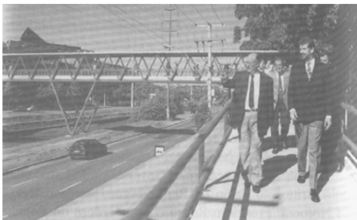
Inauguração da passarela construída pela PUCRS, sobre a Av. Ipiranga, em 11.2.1998. Reitor, Ir. Norberto Rauch e Vice-Prefeito de Porto Alegre, José Fortunati
