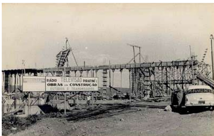
Obras da fundação e fachada da TV Piratini
