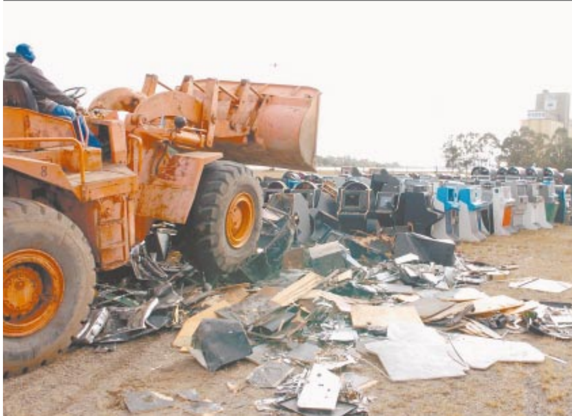
Cais do Porto, em Porto Alegre, serviu de palco para a inutilização dos equipamentos durante a manhã de ontem
