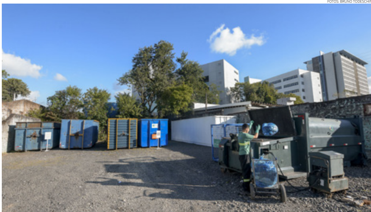
Central de Armazenamento: compactador, pesagem e containers para cada tipo de resíduo
