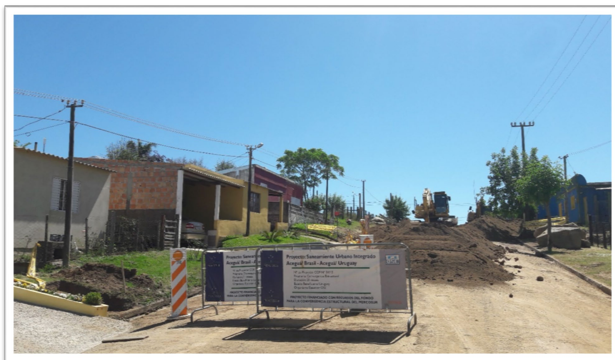
Imagem XII - Rua em Acegua/Uruguai, execução do projeto de saneamento.
