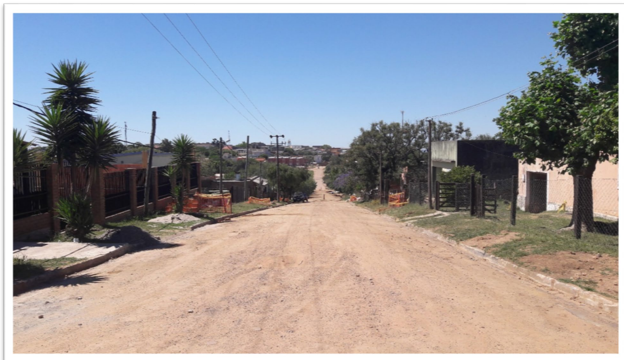
Imagem XI - Rua em Acegua/Uruguai, execução do projeto de saneamento.
