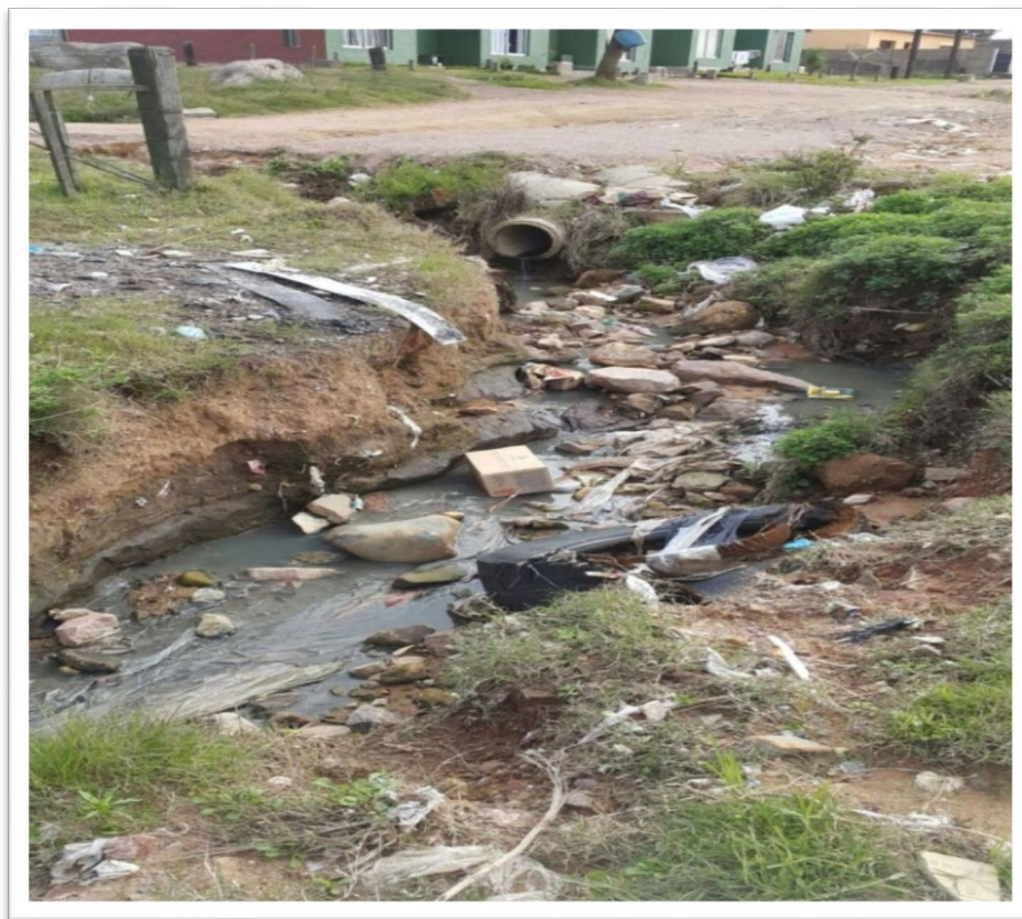
Imagem VII – Esgoto em Aceguá.
