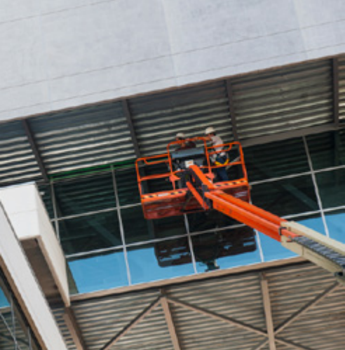
Em julho de 2015, iniciavam os reparos finais das torres do Global Tecnopuc
