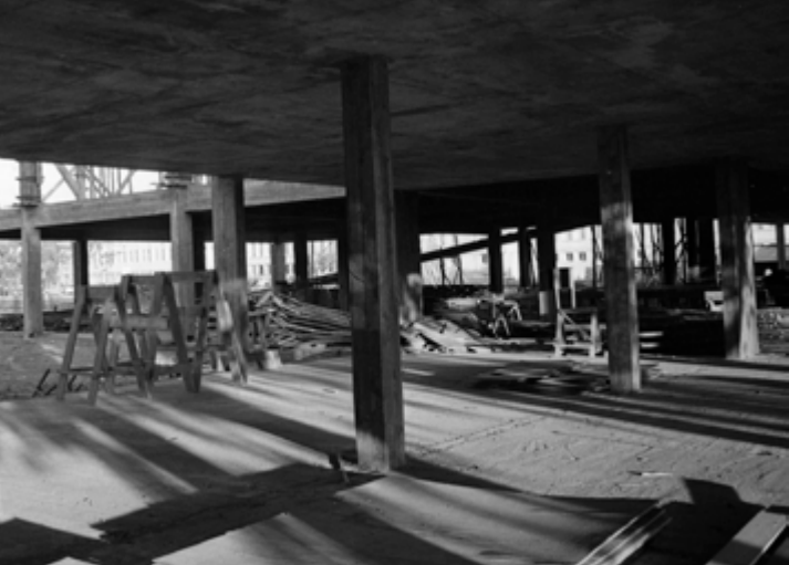
Fase inicial da construção da Biblioteca Central Irmão José Otão, em 1975
