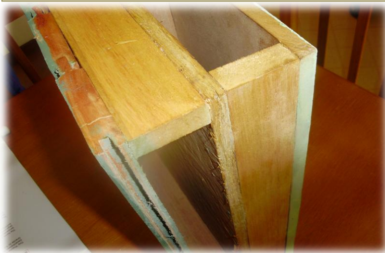
Figura 8: Colchão de ar entre paredes
